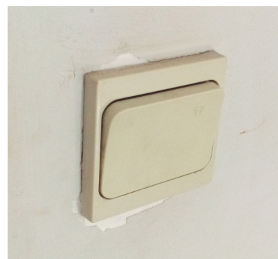
Interrupteur simple (IS03) / nombre 12
